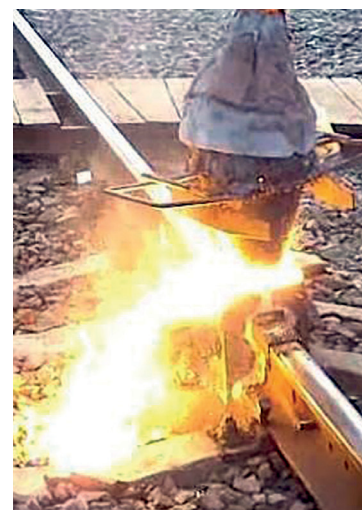
Процесс сварки рельсов
